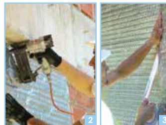
2ª Fase - Aplicação de Boltherm ao afastador 3ª Fase - Selar as juntas através fita-cola-alumínio
