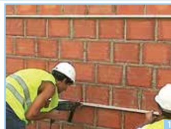
1ª Fase Fixação do afastador ao tijolo
