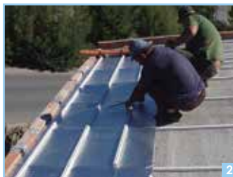
2ª Fase - Colocação de Boltherm no sentido longitudinal 3ª Fase - Selar as juntas através fita-cola-alumínio
