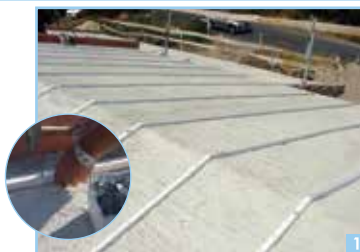
1ª Fase Fixação do afastador perpendicular ao cumo do telhado
