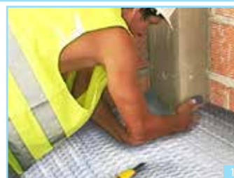
1ª Fase - Aplicação de Boltherm sobre a laje, antes da camada de regularização
