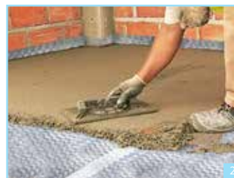
2ª Fase - Aplicação da camada de regularização
