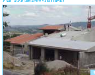
3ª Fase - Sellar as juntas através fita-cola-alumínio
