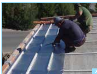
2ª Fase - Colocação de Boltherm no sentido longitudinal
