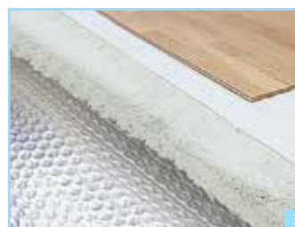
3ª Fase - Aplicação do soalho (madeira, cerâmica ou flutuante) sobre a camada de regularização
