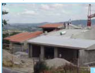
3ª Fase - Selar as juntas através fita-cola-alumínio
