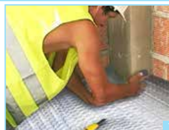
1ª Fase - Aplicação de Boltherm 131 sobre a laje, antes da camada de regularização
