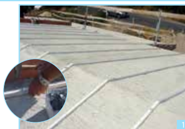
1ª Fase - Fixação do afastador perpendicular ao cumeeiro do telhado (fixação mecânica)
