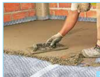
2ª Fase - Aplicação da camada de regularização
