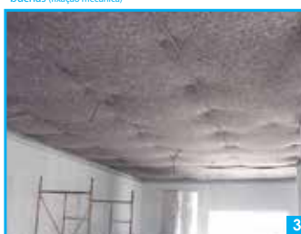
3ª Fase - Aplicação de Teto Falso
