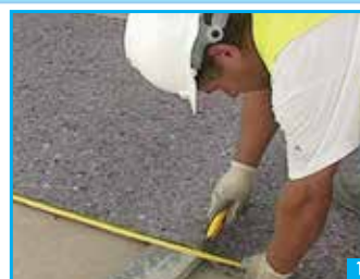
1ª Fase - Cortar o Boltherm 508 à medida desejada
