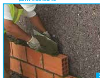
3ª Fase - Cerramento interior com parede de tijolo e respectiva caixa de ar
