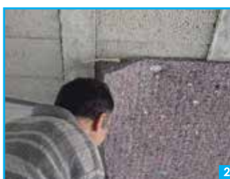
2ª Fase - Aplicação do Boltherm 508, fixação através de buchas (fixação mecânica)
