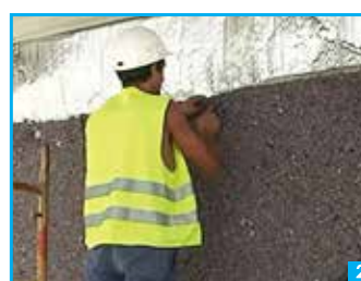
2ª Fase - Aplicação do Boltherm 503 sobre toda a área da parede (fixação mecânica)
