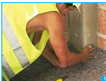
1ª Fase - Aplicação de Boltherm 501 sobre a laje, antes da camada de regularização.
