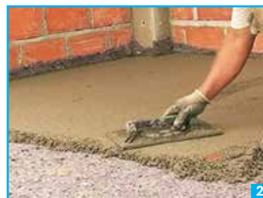
2ª Fase - Aplicação da camada de regularização
