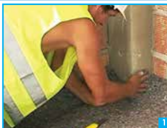
1ª Fase - Aplicação de Boltherm 503 sobre a laje, antes da camada de regularização.
