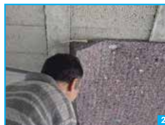
2ª Fase - Aplicação do Boltherm 503, fixação através de buchas (fixação mecânica)
