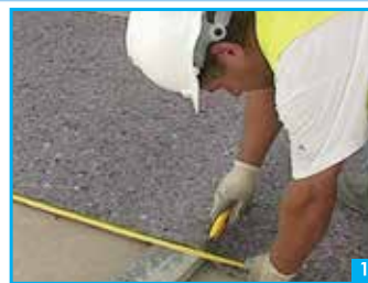
1ª Fase - Cortar o Boltherm 503 à medida desejada
