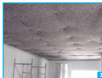
3ª Fase - Aplicação de Teto Falso
