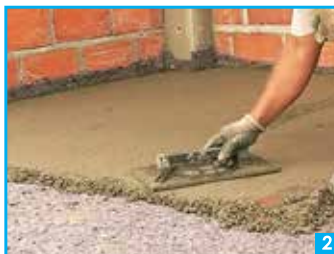
2ª Fase - Aplicação da camada de regularização
